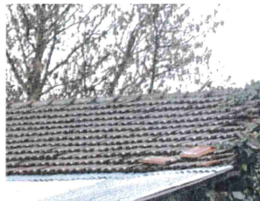
tuiles à remplacer
