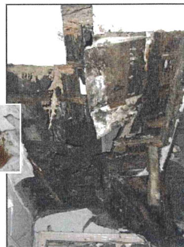
Plancher dégradé par les mûrles
