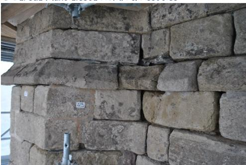
Ainsi, les infiltrations d'eau dégradent progressivement l'ensemble du bâtiment et constituent sur le long terme une menace pour sa stabilité.
