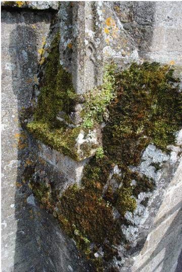
par pierre, afin de remplacer, retailler ou greffer les parements et lamiers dégradés ainsi que les pinacles (couronnements des contreforts), de retirer les développements végétaux, et de purger et restaurer les joints.
