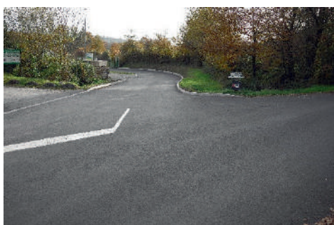
Entrée de la déchetterie
