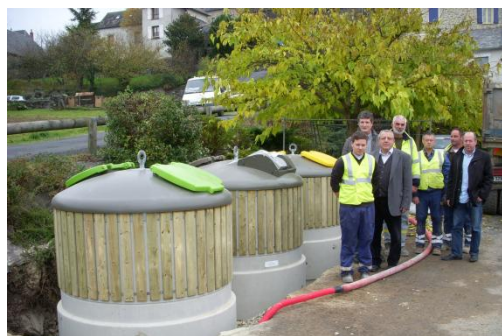
Installation des colonnes semi-enterrées au village de « Travassac »
