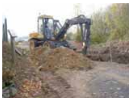
Assainissement des eaux usées de Mazières (travaux en cours)
