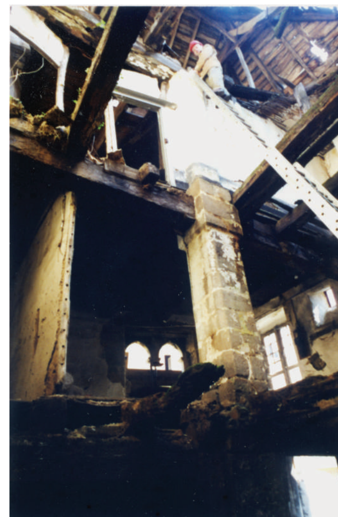
L'espace intérieur de la maison au début des travaux - l'architecte observe son état depuis le haut de l'échelle appuyée contre le pilier central médiéval (Photo P. Conte)
