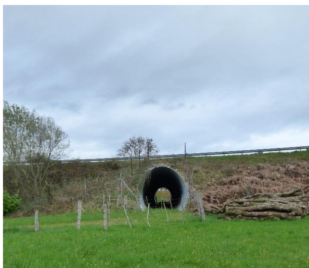
Tunnel de franchissement sous l'autoroute A20
